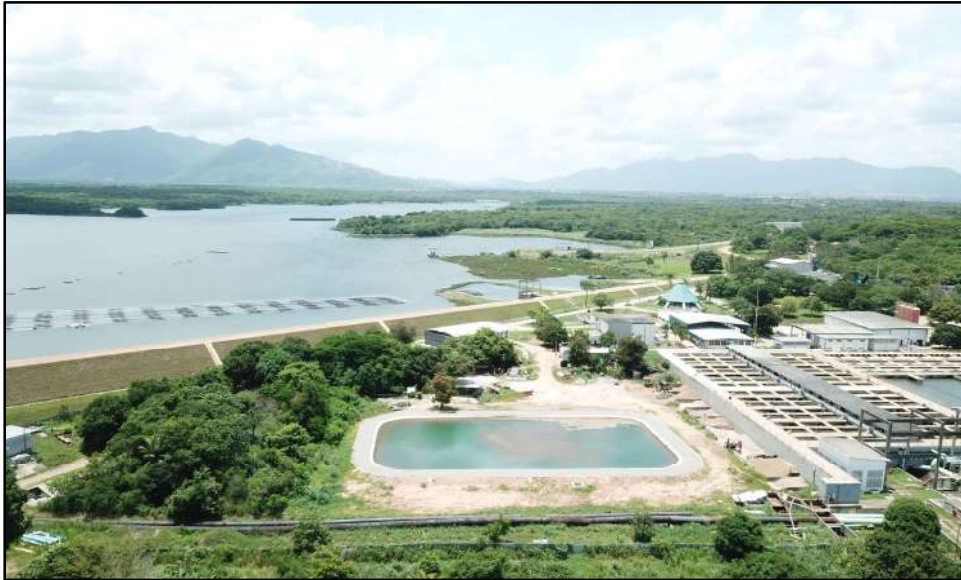
BH Metropolitana – Açude Gavião – Barragem e ETA -Fortaleza/CE
