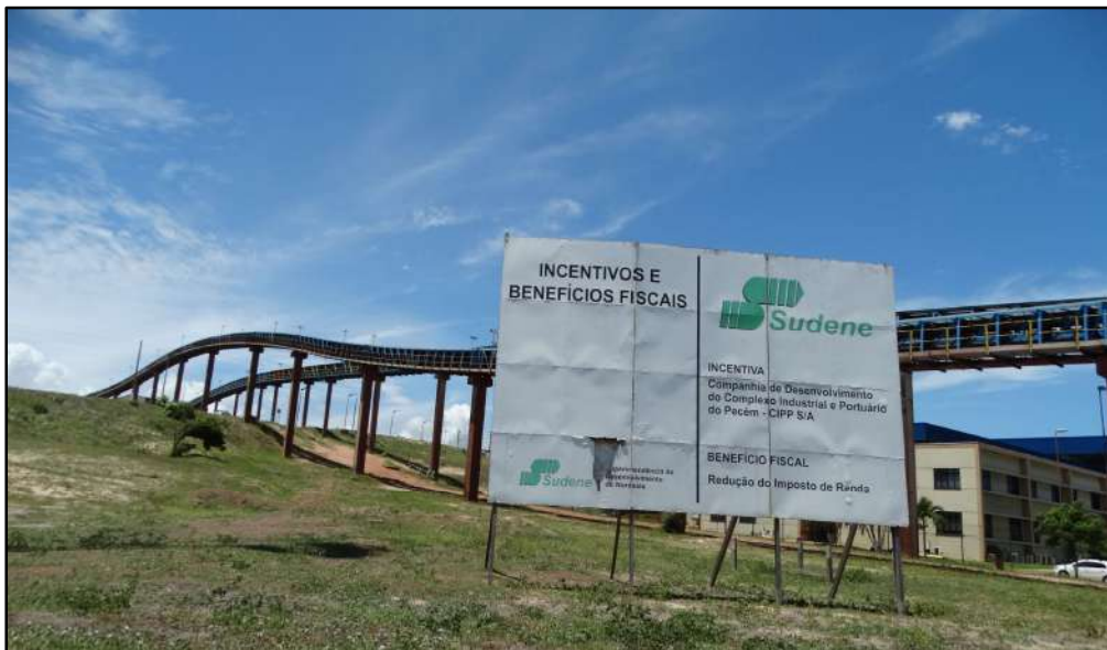
RH6 – BH Metropolitana – Instalações Industriais - Porto do Pecém - Pecém/CE
