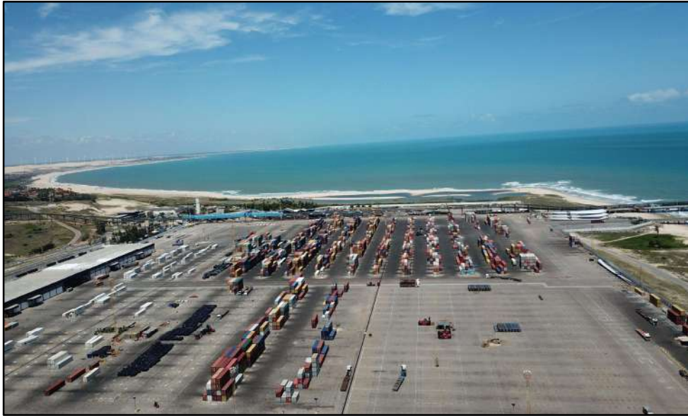
RH6 – BH Metropolitana – Instalações Industriais - Porto do Pecém - Pecém/CE
