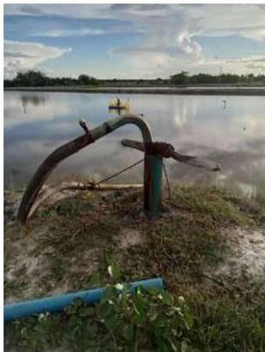
(i) Captação subterrânea na margem do rio.
