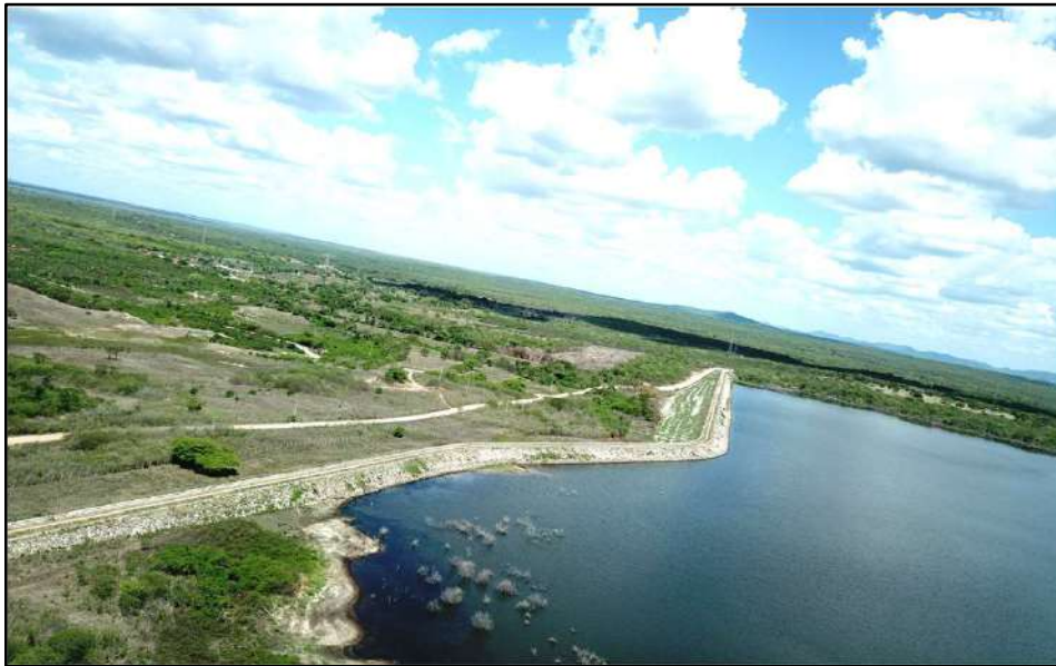
Barragem Macacos – Quixadá/CE – Vista da Barragem da Margem Direita
