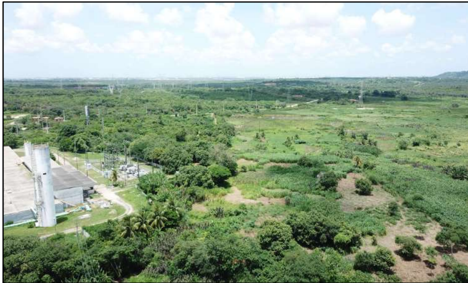
BH Metropolitana – Açude Gavião – Área de Jusante da Barragem - Fortaleza/CE
