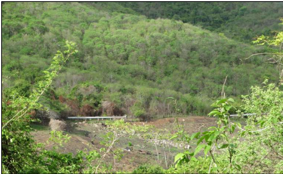
Barragem Acarape do Meio – Adutora de Água Bruta - Redenção/CE
