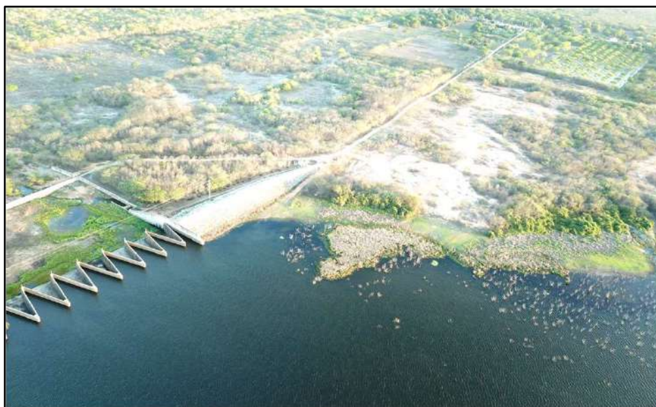
Barragem Batente – Quixadá/CE – Vista Aérea Geral
