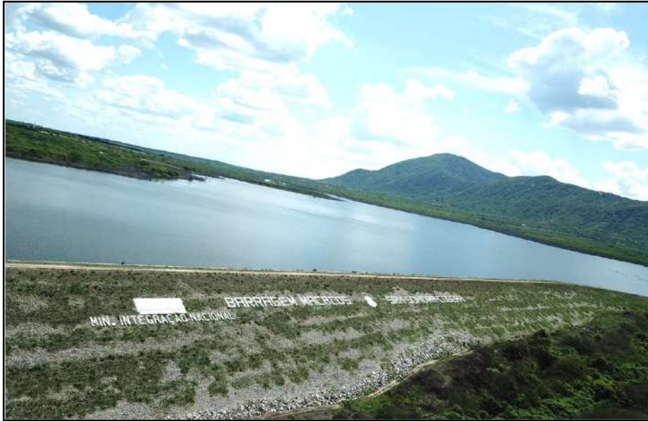
Barragem Macacos – Quixadá/CE – Barragem da Margem Esquerda
