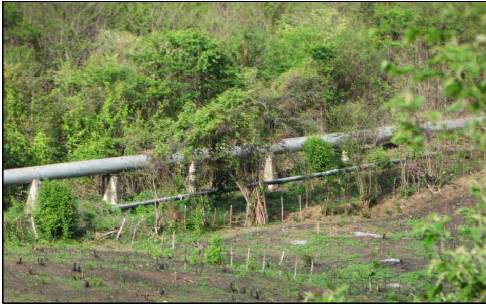
Barragem Acarape do Meio - Redenção/CE – Paramento de Jusante
