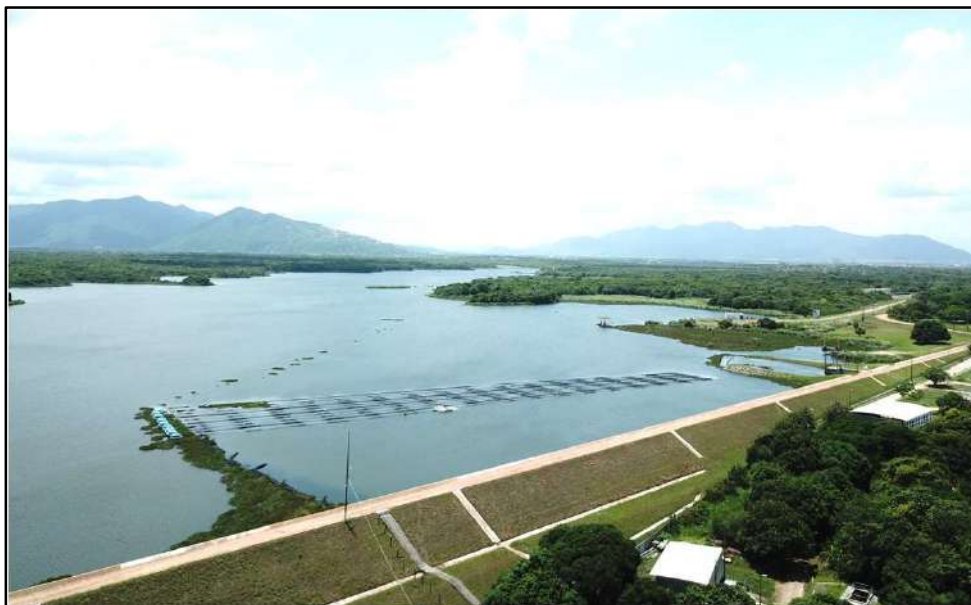
BH Metropolitana – Açude Gavião – Barragem e ETA -Fortaleza/CE
