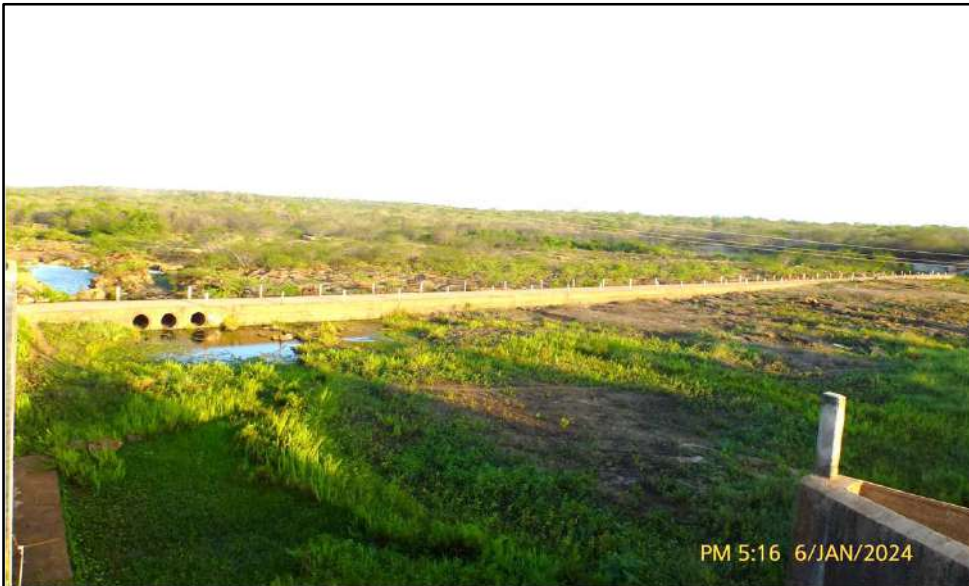
Barragem Batente – Quixadá/CE – Canal de Restituição do Sangradouro e Passagem Molhada de Jusante
