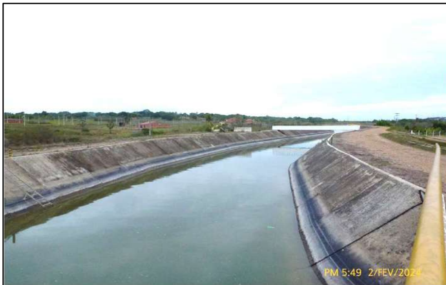
RH6 – BH Metropolitana – Canal do Eixão das Águas em Pacaju/CE
