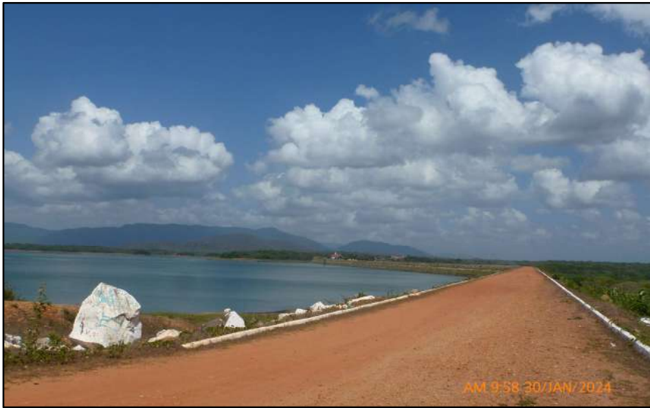
BH Metropolitana – Barragem do Açude Pacoti – Pacaju/CE
