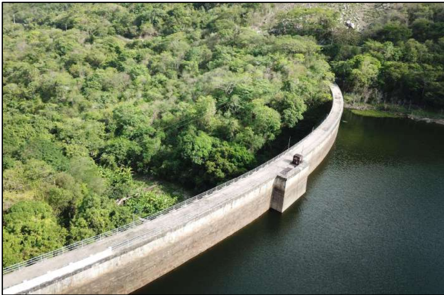
Barragem Acarape do Meio - Redenção/CE – Barragem de Pedra Argamassada
