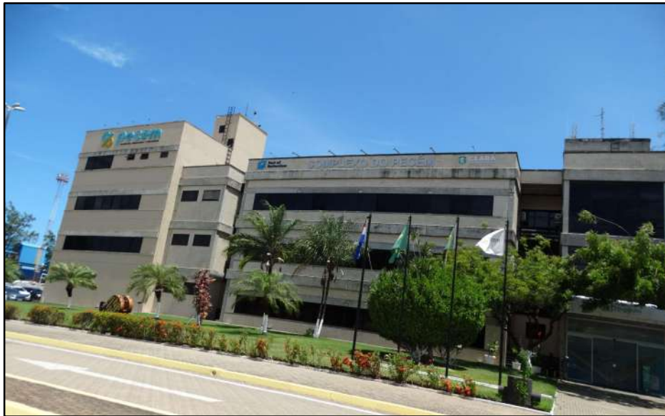
RH6 – BH Metropolitana – Instalações Industriais - Porto do Pecém - Pecém/CE
