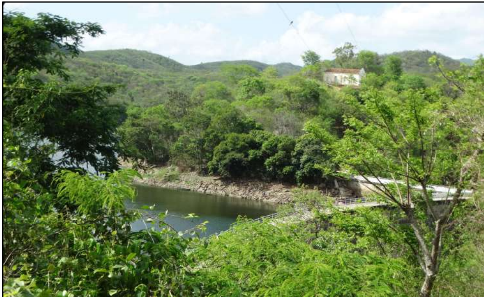
Barragem Acarape do Meio - Reservatório e Entorno - Redenção/CE
