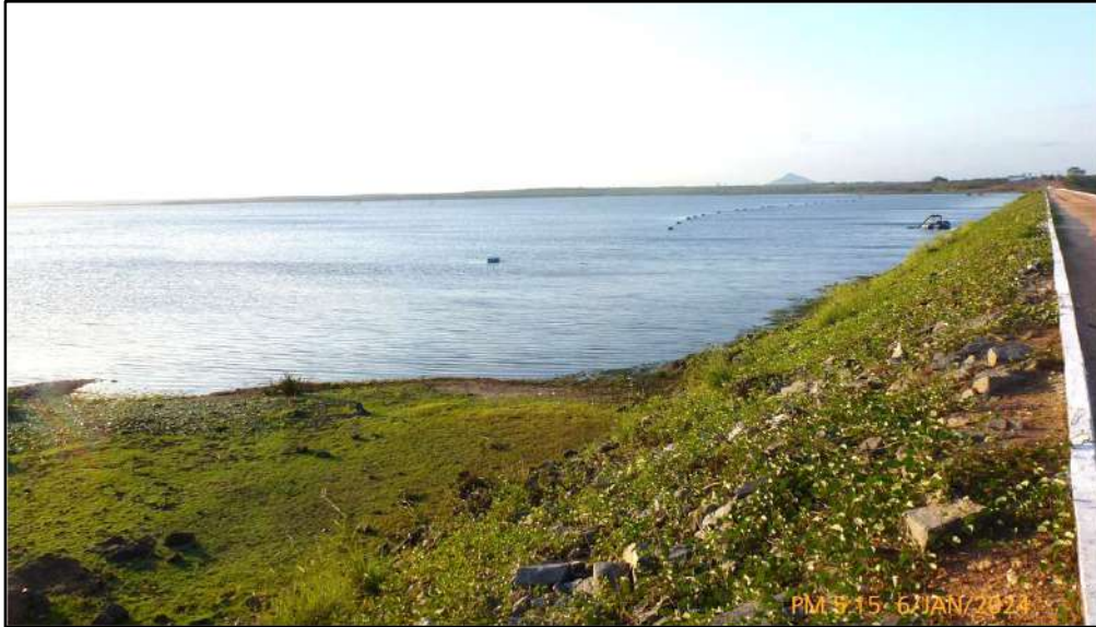
Barragem Batente – Quixadá/CE – Reservatório, Talude de Montante e Crista e da Barragem MD
