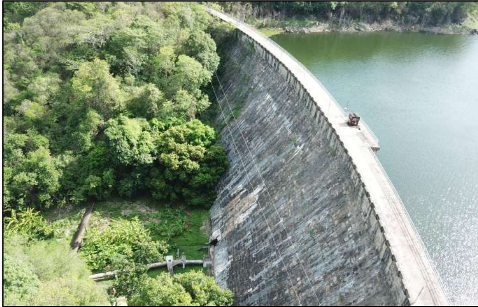
Barragem Acarape do Meio - Redenção/CE – Paramento de Jusante e Descarregador de Fundo
