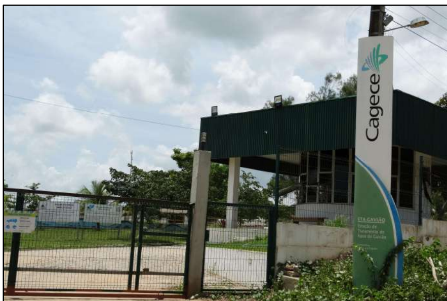
BH Metropolitana – Açude Gavião – Barragem e ETA -Fortaleza/CE
