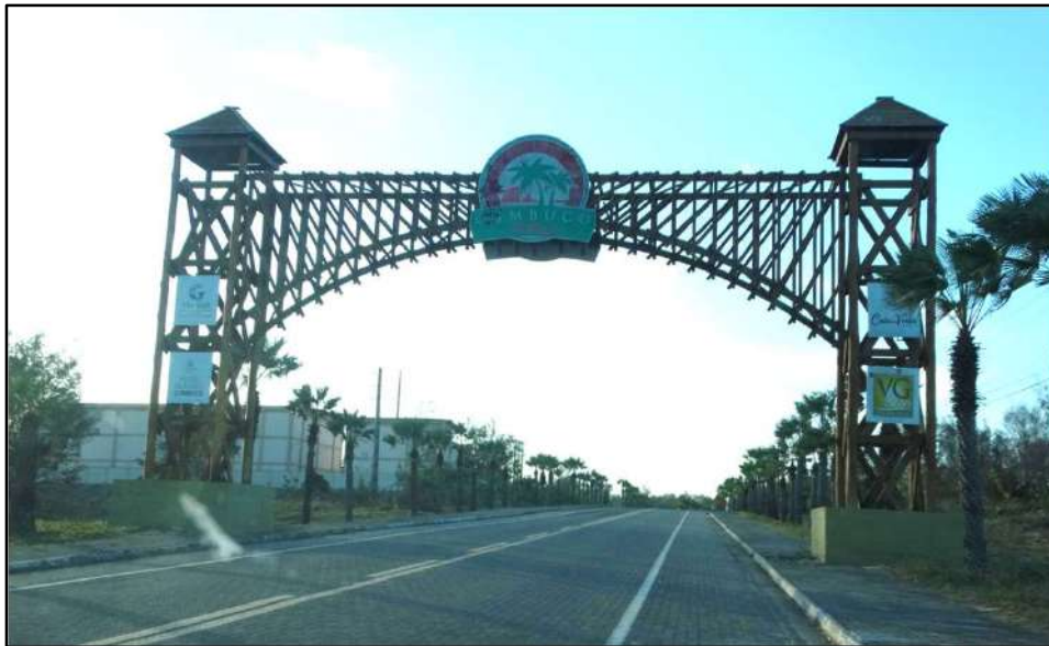
RH6 – BH Metropolitana – Instalações Turísticas e Condomínios – Praias do Cumbuco - Fortaleza/CE
